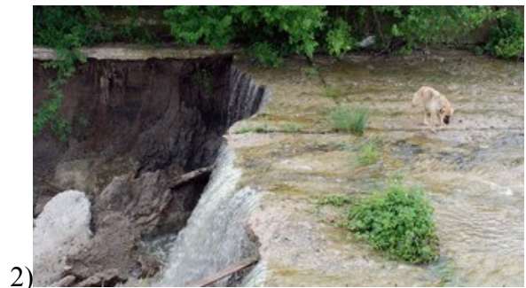
Снимки №1, 2 - 1) възстановена част на яз. Балъкли Дере, 2) разрушение на бързотока на яз. Стамболийски
