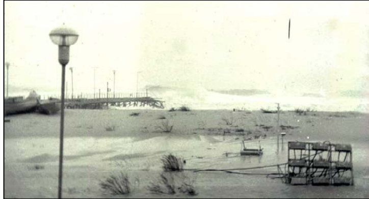
Фиг. 3: Разрушителен ефект от силното вълнение и значителното покачване на морското ниво на 19 февруари 1979 година в НИК към Института по океанология в Шорпиловци.
